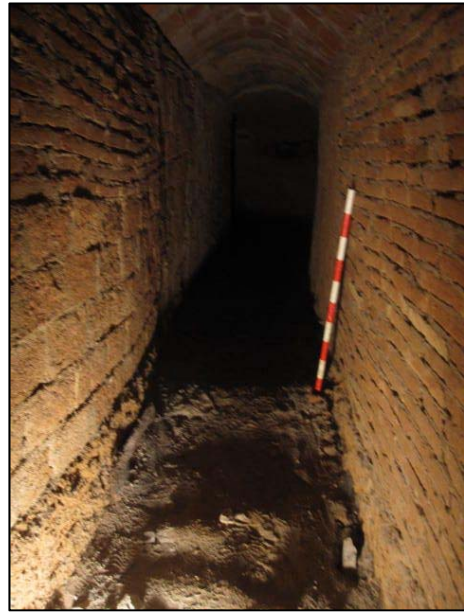
FOTO 10. Vista del passadís de l'hipogeu (UE 16), amb el revestiment de les parets i el sostre (UE 18).
