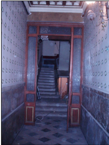
FOTO 1. Vista general del replà a on s'ubicarà l'ascensor, abans inici de les obres.
