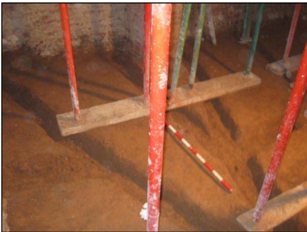
FOTO 7. Vista general de les rases de l'interior del soterrani.
